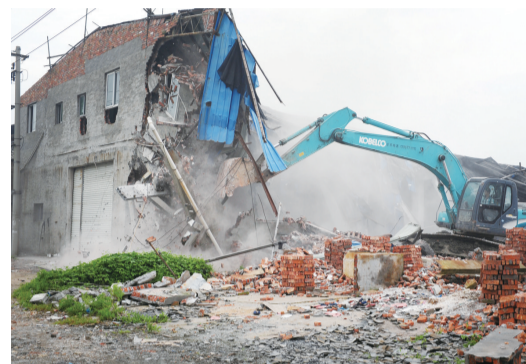
小微企业创业园内拆违现场
