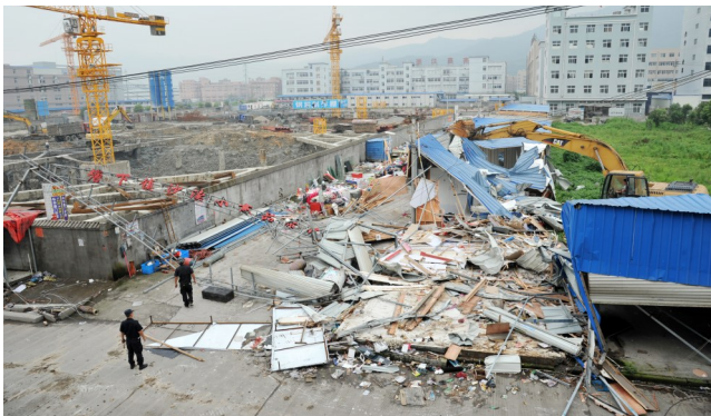
沙岙村拆除违章建筑被拆除
