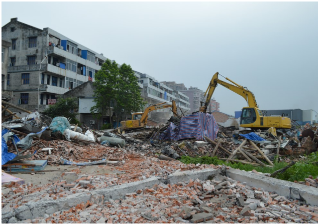
新安村拆违现场
