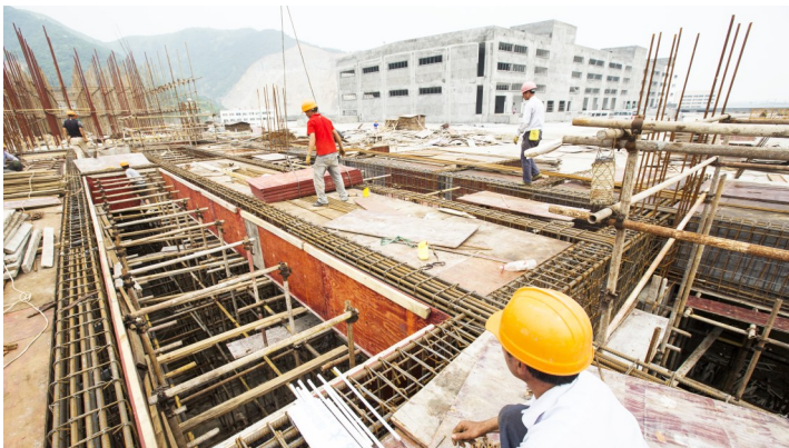
仓储中心建设现场
