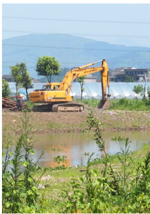
曹村港老河边上正在用松木护岸
