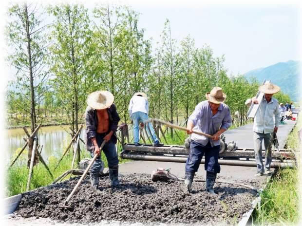
工人在天井垟河边铺设道路
