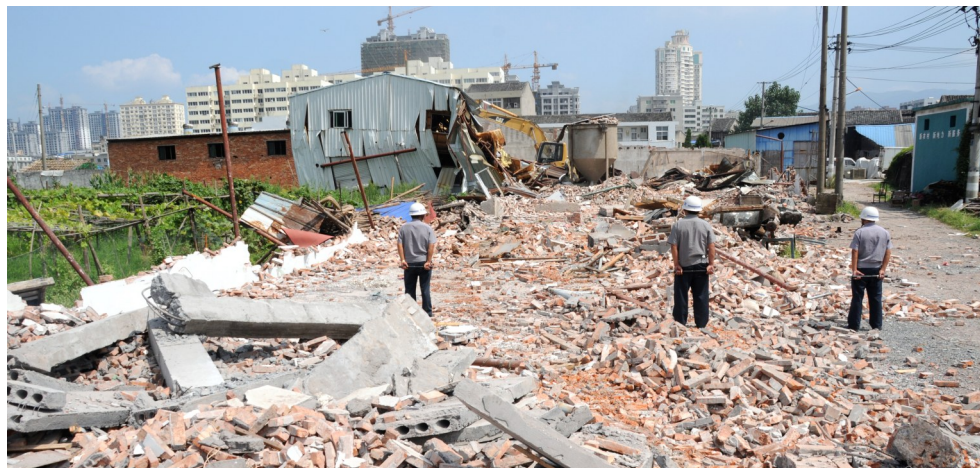
塘西拆违现场
