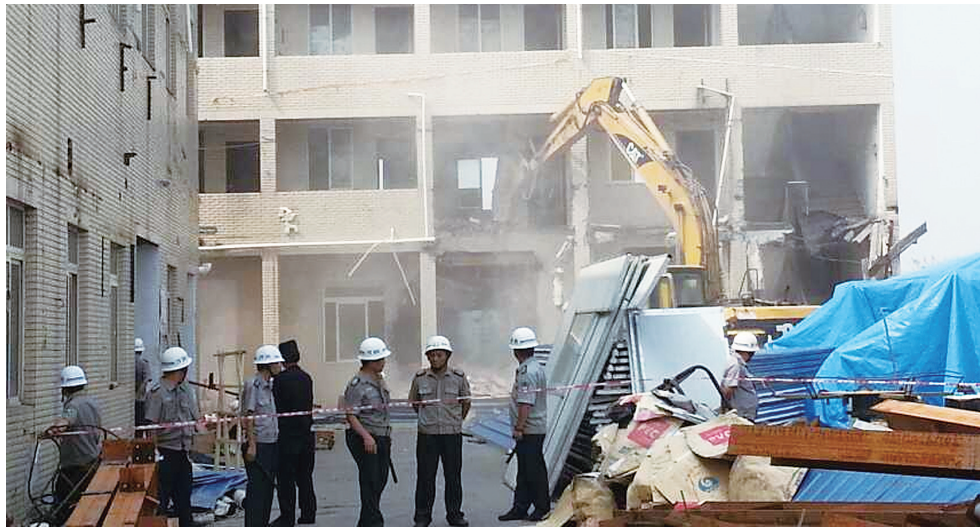
浦桥村拆违现场
