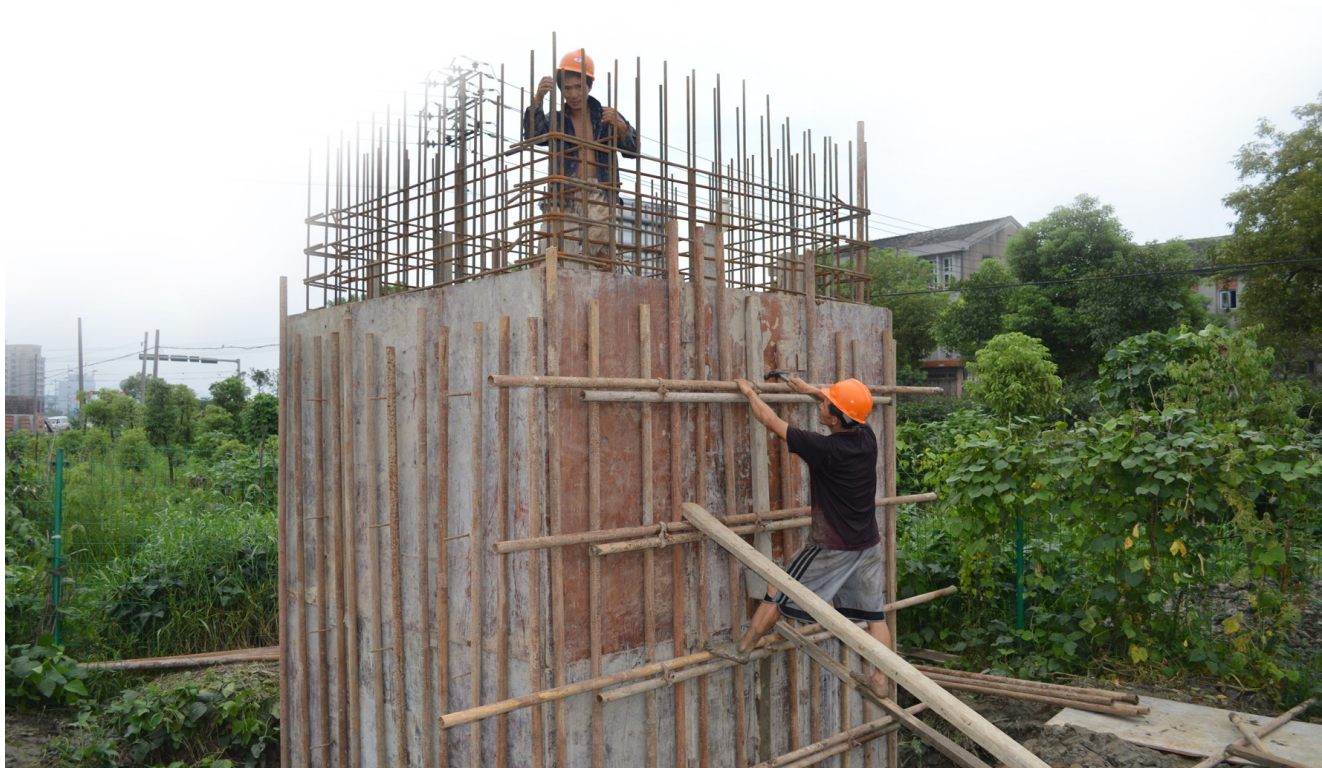
施工人员加固瑞云社区河东区块沉井
