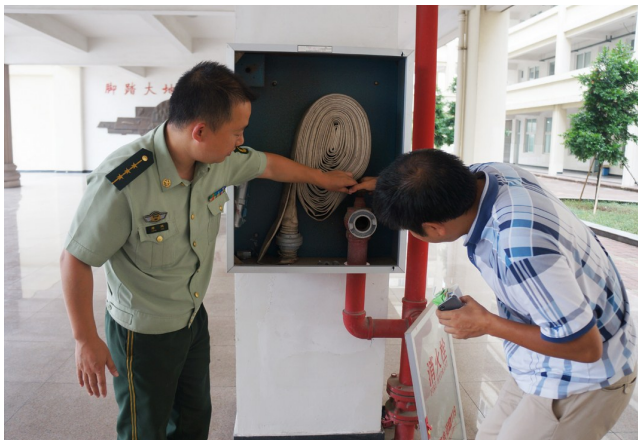
执法人员检查消防栓情况
