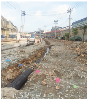
罗梅公路施工现场
