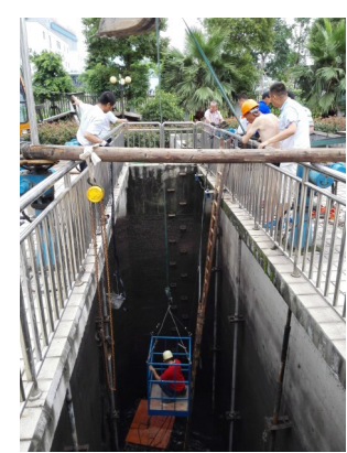
工作人员下污水井作业
