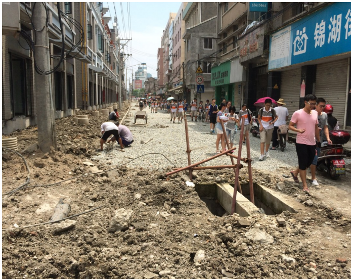
学生们走在正在施工的道路上
