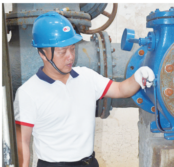
苏克在排污泵站检查设备
