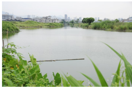
西南河整治前后对比(记者 杨微微)
