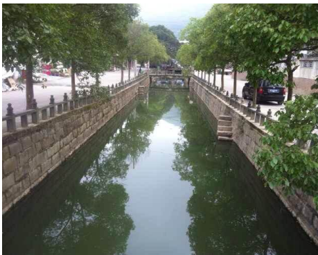
新居河整治前后对比(记者 钱枫枫)
