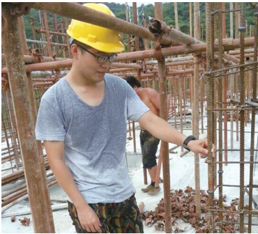
施泓津检查钢筋焊接是否牢固
