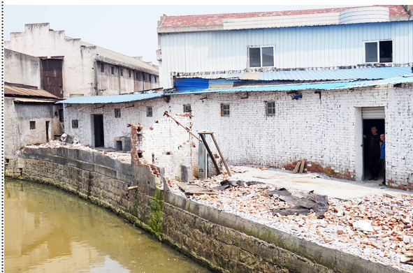
今年6月海安龙河拆违现场
