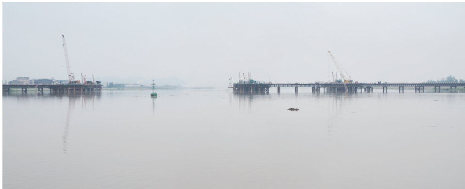
正在建设中的飞云江六桥
