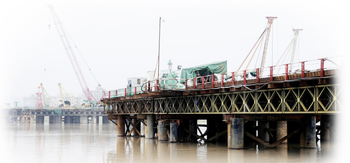
正在建设中的飞云江六桥
