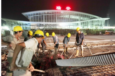
2009年9月17日,施工人员挑灯夜战迎通车。
