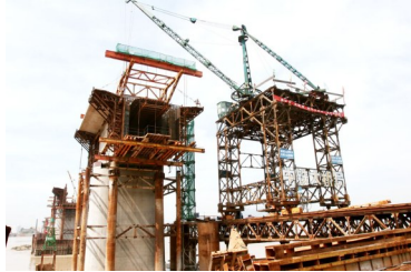
2007年7月5日,温福铁路飞云江特大桥主跨连续梁全面施工。
