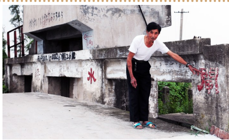
场桥水闸保留至今
