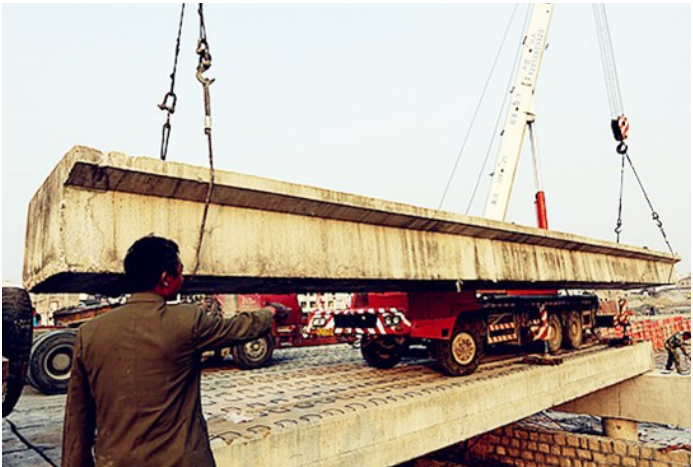
塘河大桥最后一块梁板吊装
