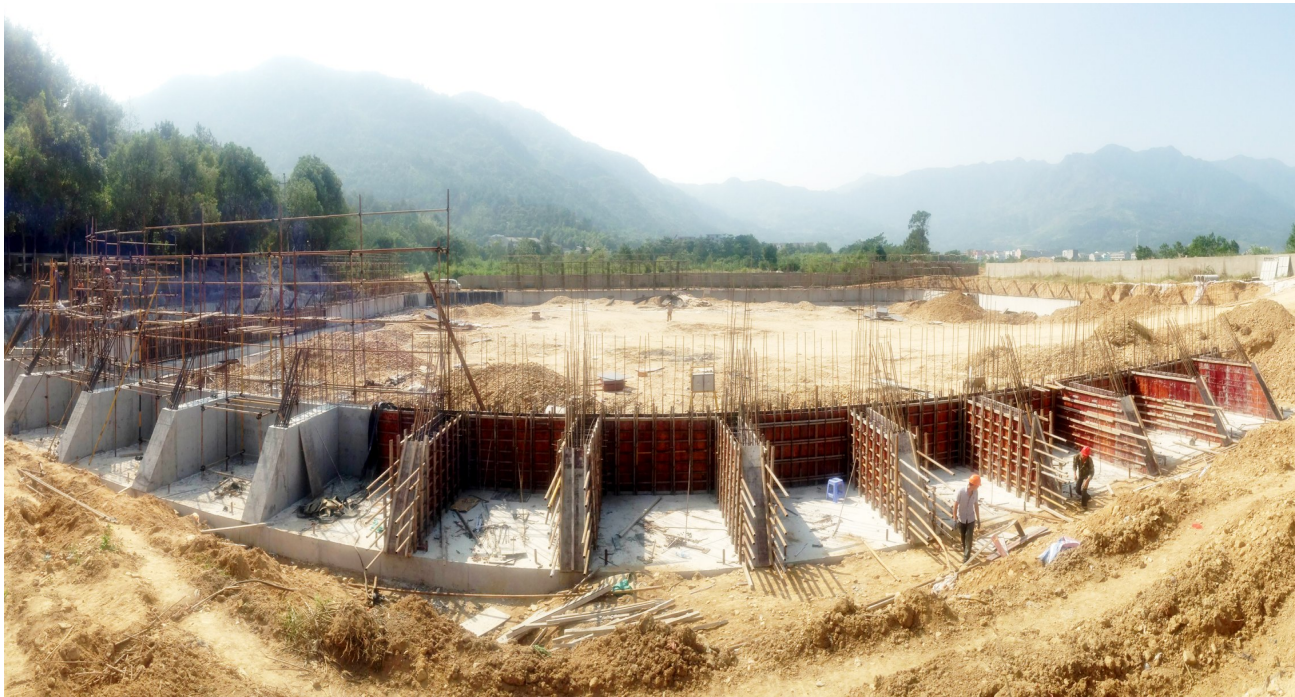
湖岭污水处理厂施工现场
