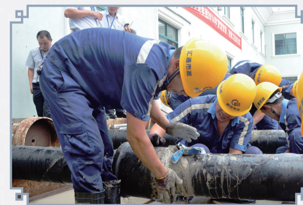
管道带水打箍比赛现场
