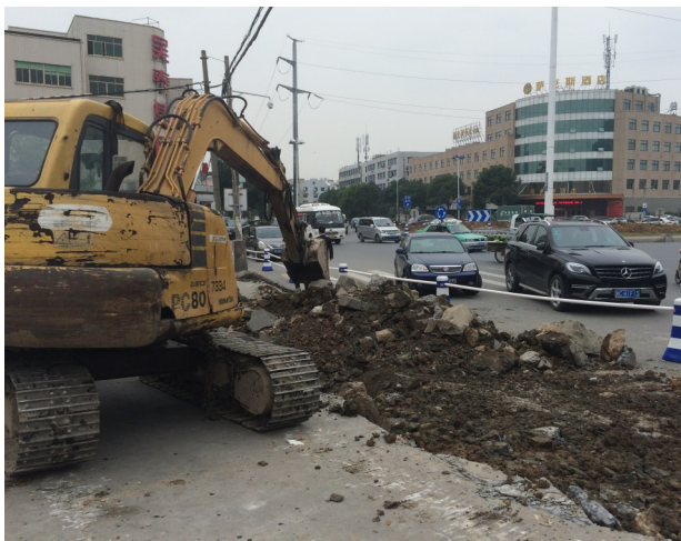
环岛附近已开始施工
