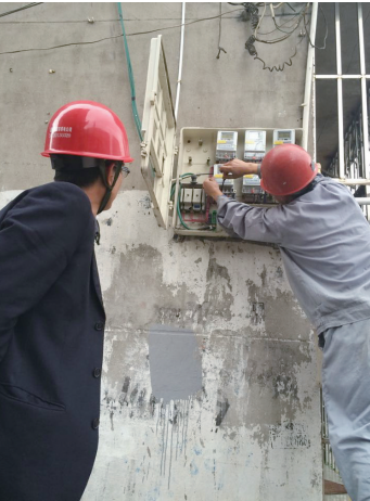
执法人员对存在安全隐患的出租房采取停电措施
