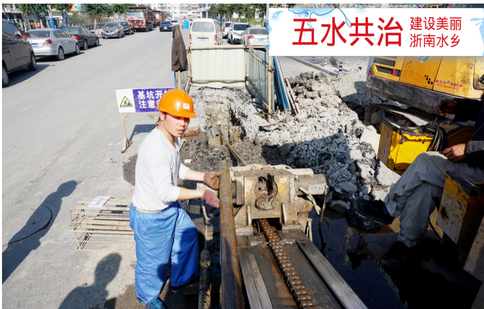
工人正在大桥西路的截污纳管工地上施工
