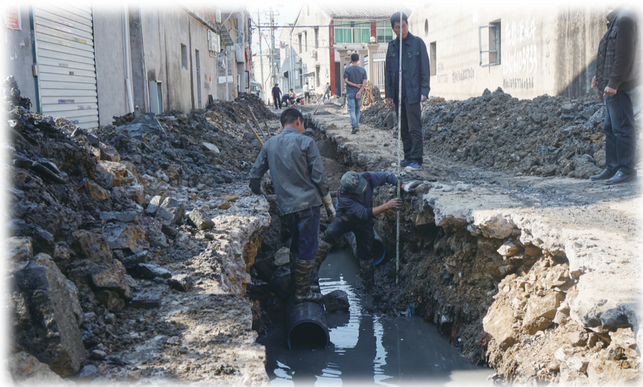
工人在铺设农村生活污水排放管道
