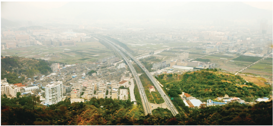
道路左侧为新居村,右侧为“蛤蟆山”(特约记者 徐洪姆/摄)
