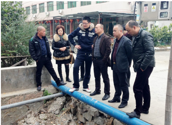
市黑臭河整治验收小组在实地检查
