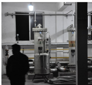
工作人员坚守气化炉到午夜
