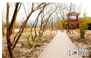
石桥、古亭、竹林、幽径、群山……飞云江绿道江洲岛段工程
