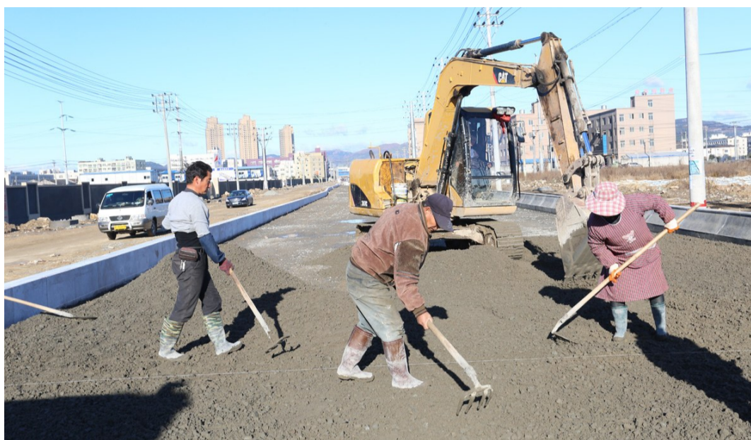
富周东路施工现场
