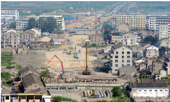
万松东路延伸线(2014年9月1日) 陈立波 / 摄
