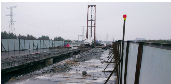
渠化工程在施工中
