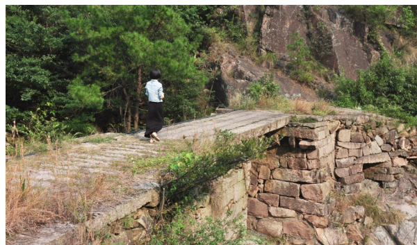
福泉山白云岭古道一带的古桥梁
