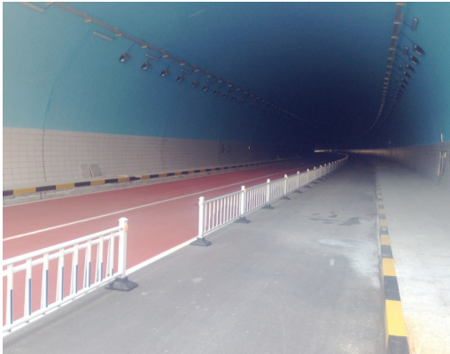
万松山隧道东口（临院士路）内部
