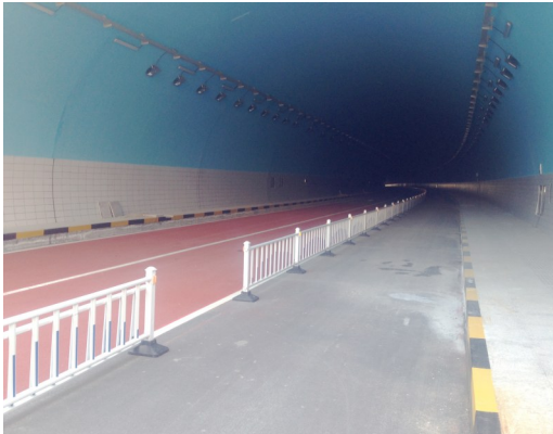
万松山隧道东口(临院士路)内部
