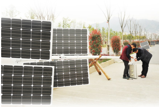
工作人员正在组装路灯
