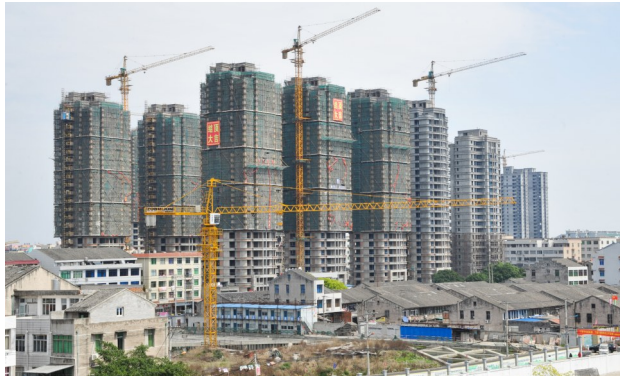
后里E、G组团旧村改造工程结顶
