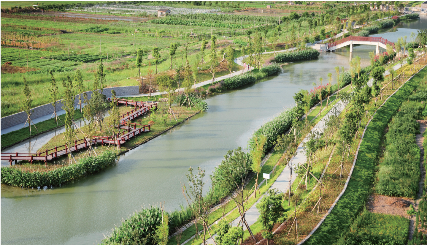
塘下镇八水泱生态治水工程项目现场 陈立波 摄
