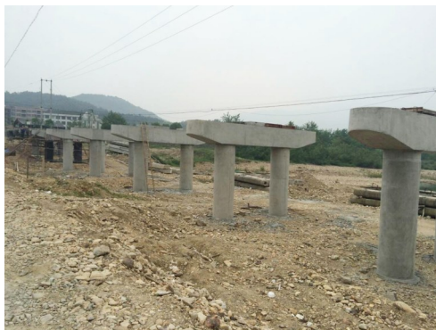
完成浇筑的新桥墩
