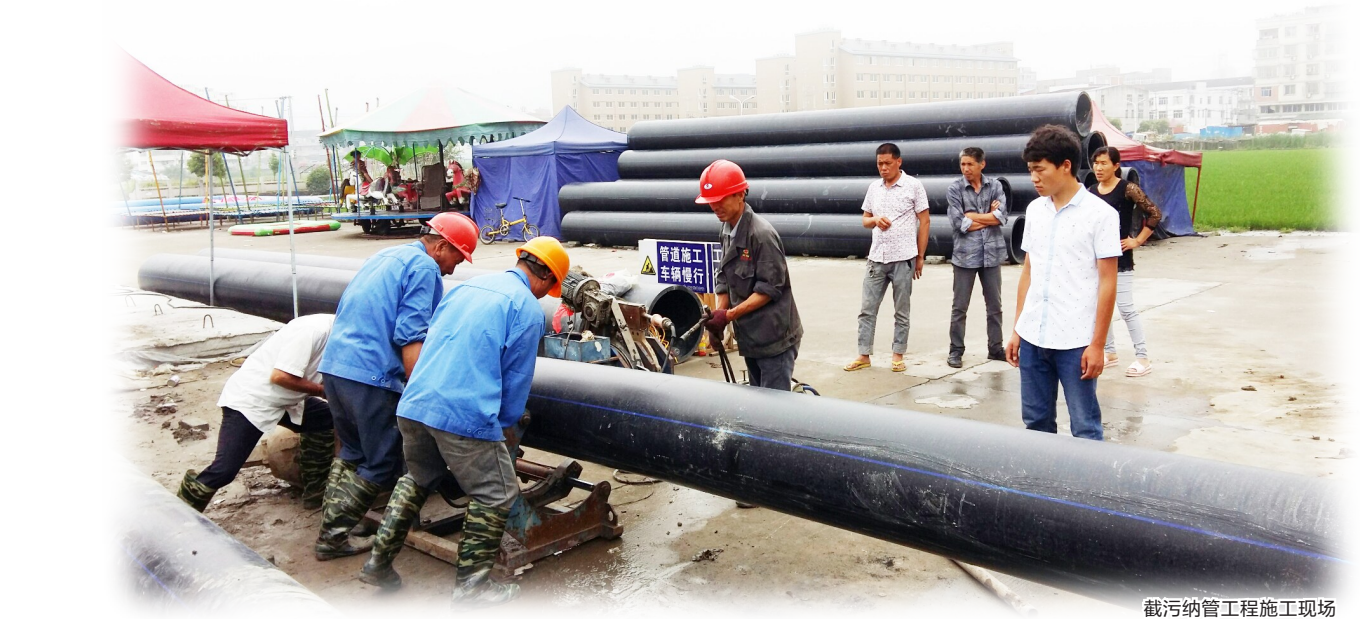
截污纳管工程施工现场
