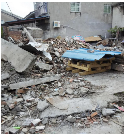
违建拆除后残留了不少建筑垃圾
