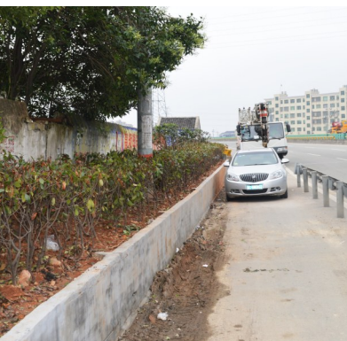
瑞安大桥接线与104国道交叉口整治前后对比
