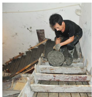
泥水工在拆除木楼梯
