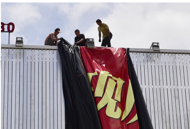
台风来临前,塘下赵宅装潢市场,工作人员在拆解广告牌。(记者 陈立波)
