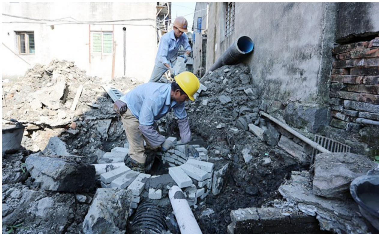
东山街道中埠村截污纳管一期工程施工现场
