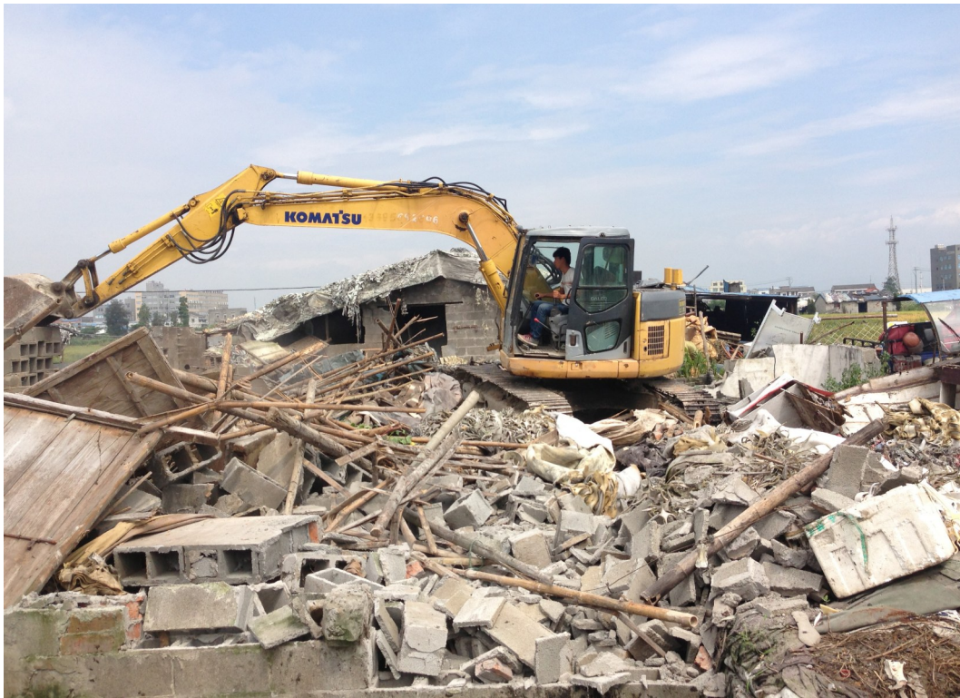
繁荣村违章养殖场被拆除
