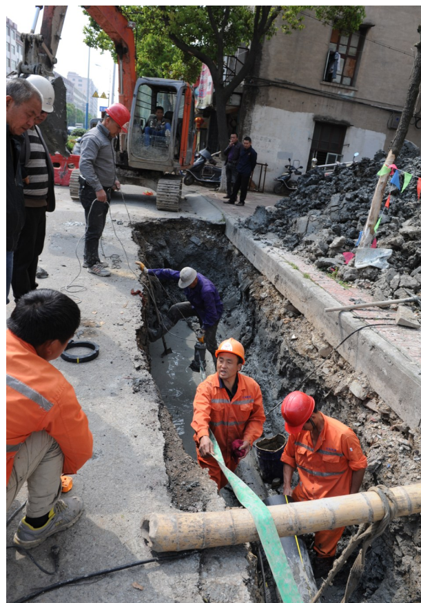
通讯电缆工人在施工
