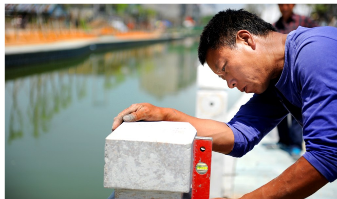
东山横河安装护栏工人
