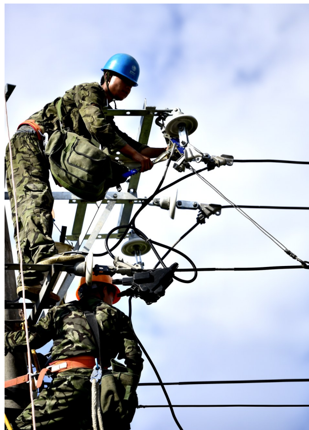
仙桥电力维修工人
