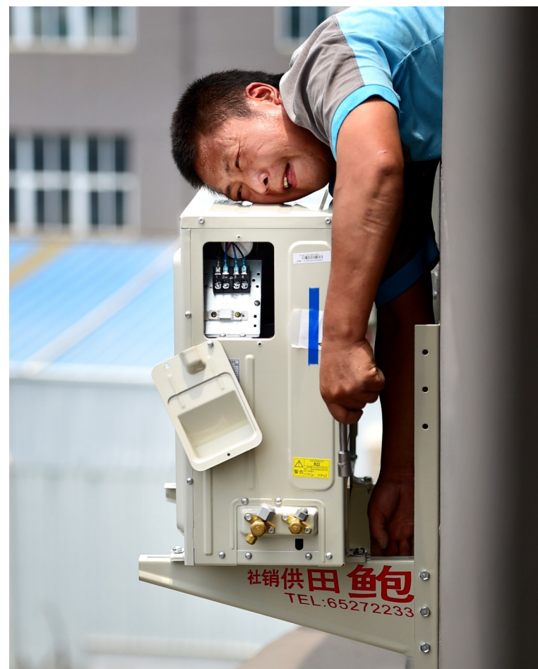
塘下一家电公司的空调安装师傅
