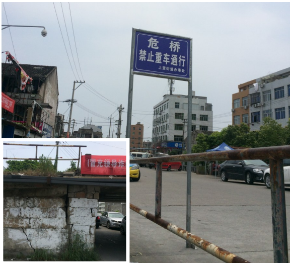
桥头设立警示牌
