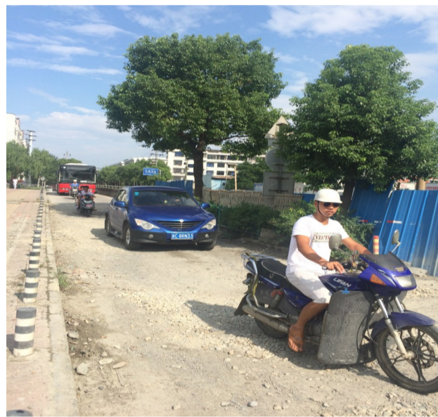
瑞湖桥施工路段车流量大
